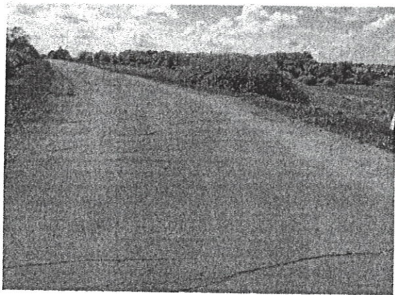
Рис.3 Вид на проезжую часть
