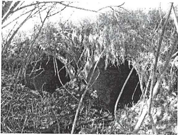
Рис.1 Общий вид входного оголовка
